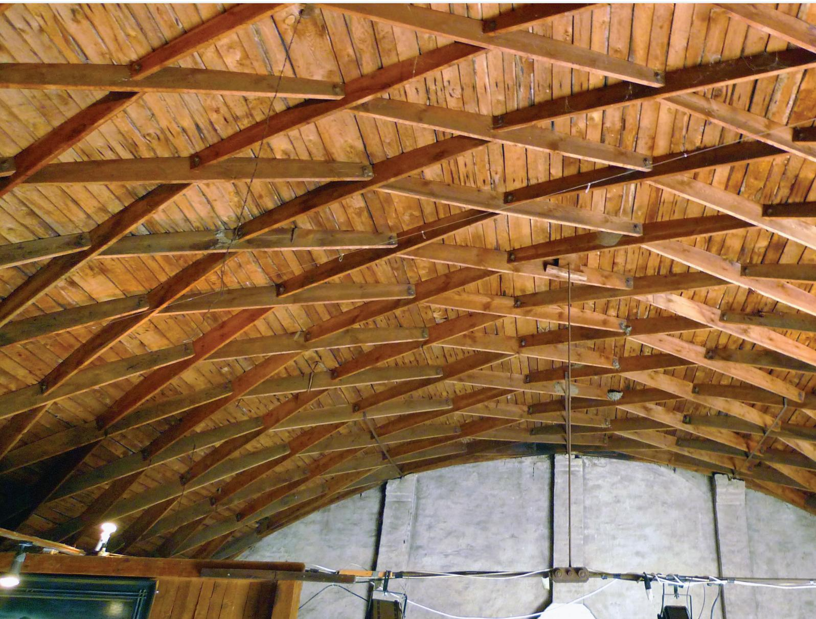
Abbildung 1: Denkmalgeschütztes Scheunendach mit Zollinger-Konstruktion
