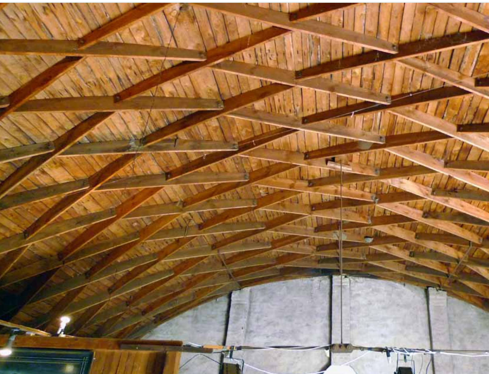
Abbildung 1: Denkmalgeschütztes Scheunendach mit Zollinger-Konstruktion
