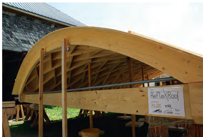
Bild 8. Belastungstests auf der Baustelle (Fotos/Grafiken: HTWK Leipzig, Forschungsgruppe FLEX)
