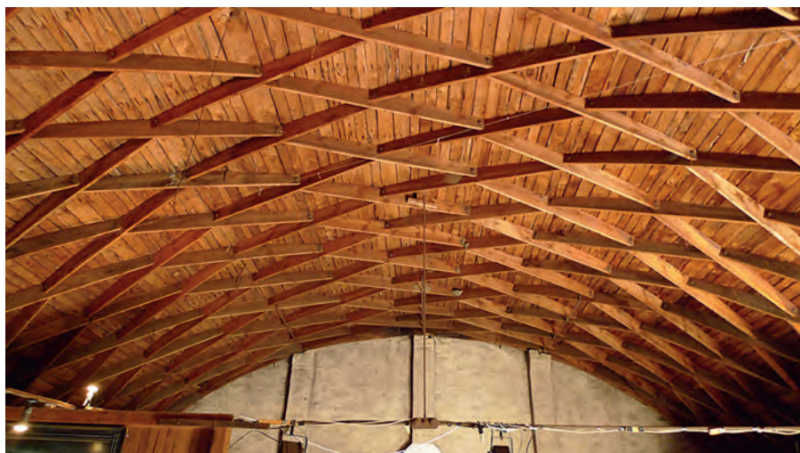
Bild 1. Denkmalgeschütztes Scheunendach mit Zollinger-Konstruktion
