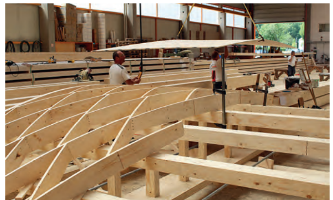
Bild 7. Herstellen der Segmente unter Werkstattbedingungen
